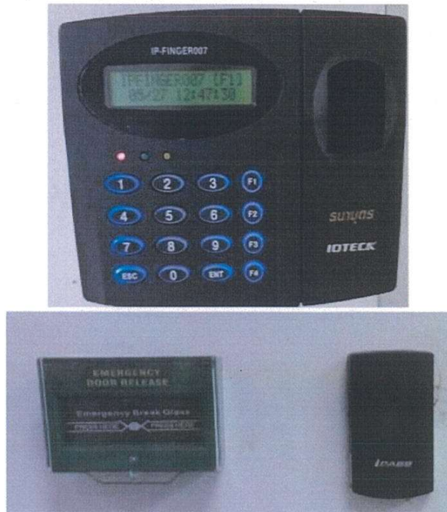
๖๐. ระบบการควบคุมการเข้าออกอัตโนมัติ (Access Control)
