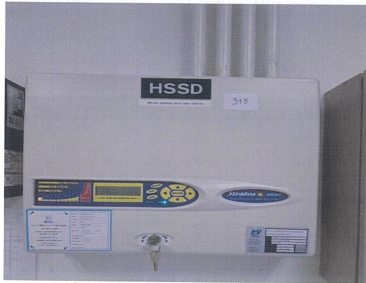
๕๘. ระบบตรวจจับควันไฟความไวสูง
